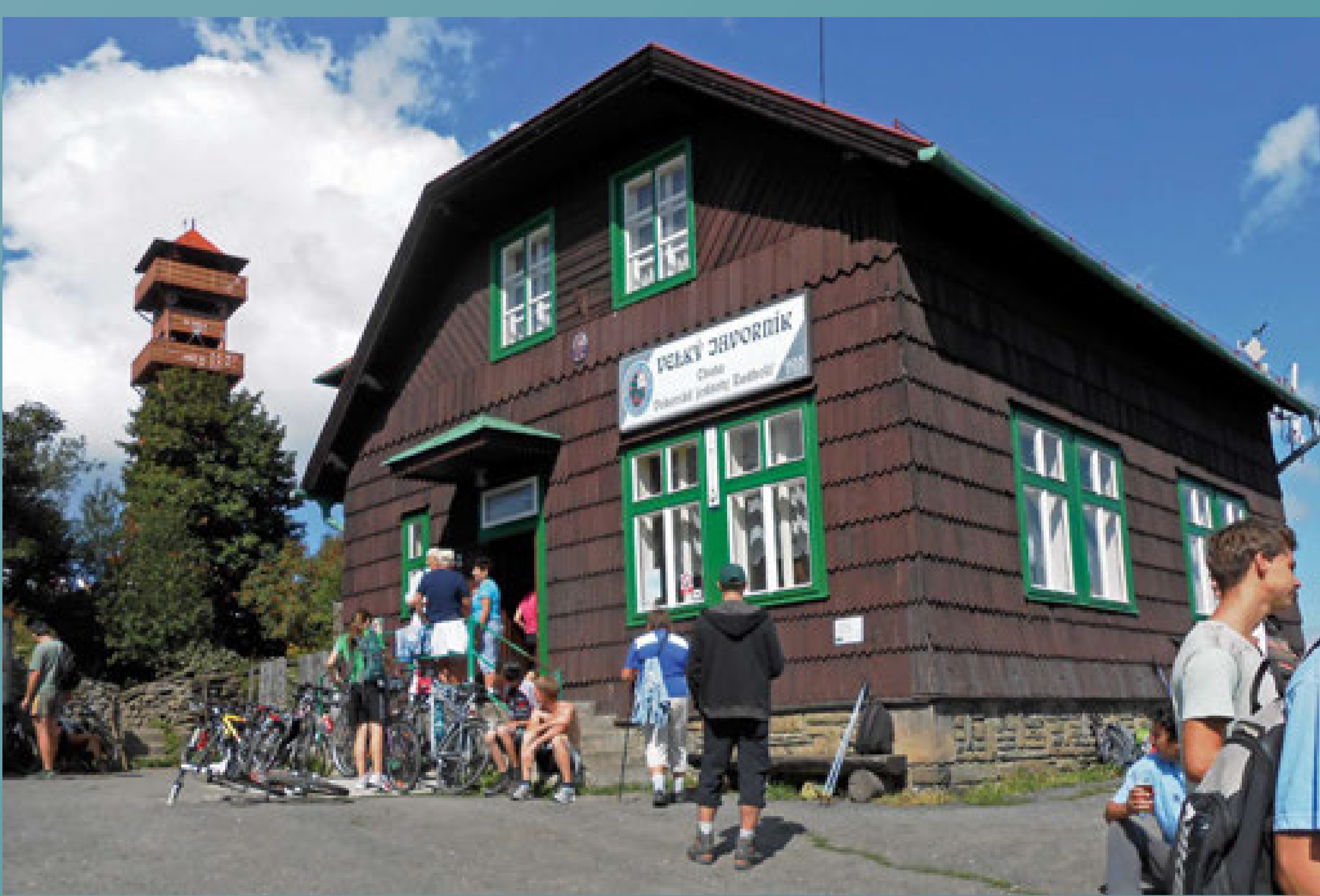
Chata Pohorské jednoty Radhošť na Velkém Javorníku Postavena PJR v letech 1934–1935. V pozadí rozhledna Lesů ČR uvedená do provozu v roce 2013
