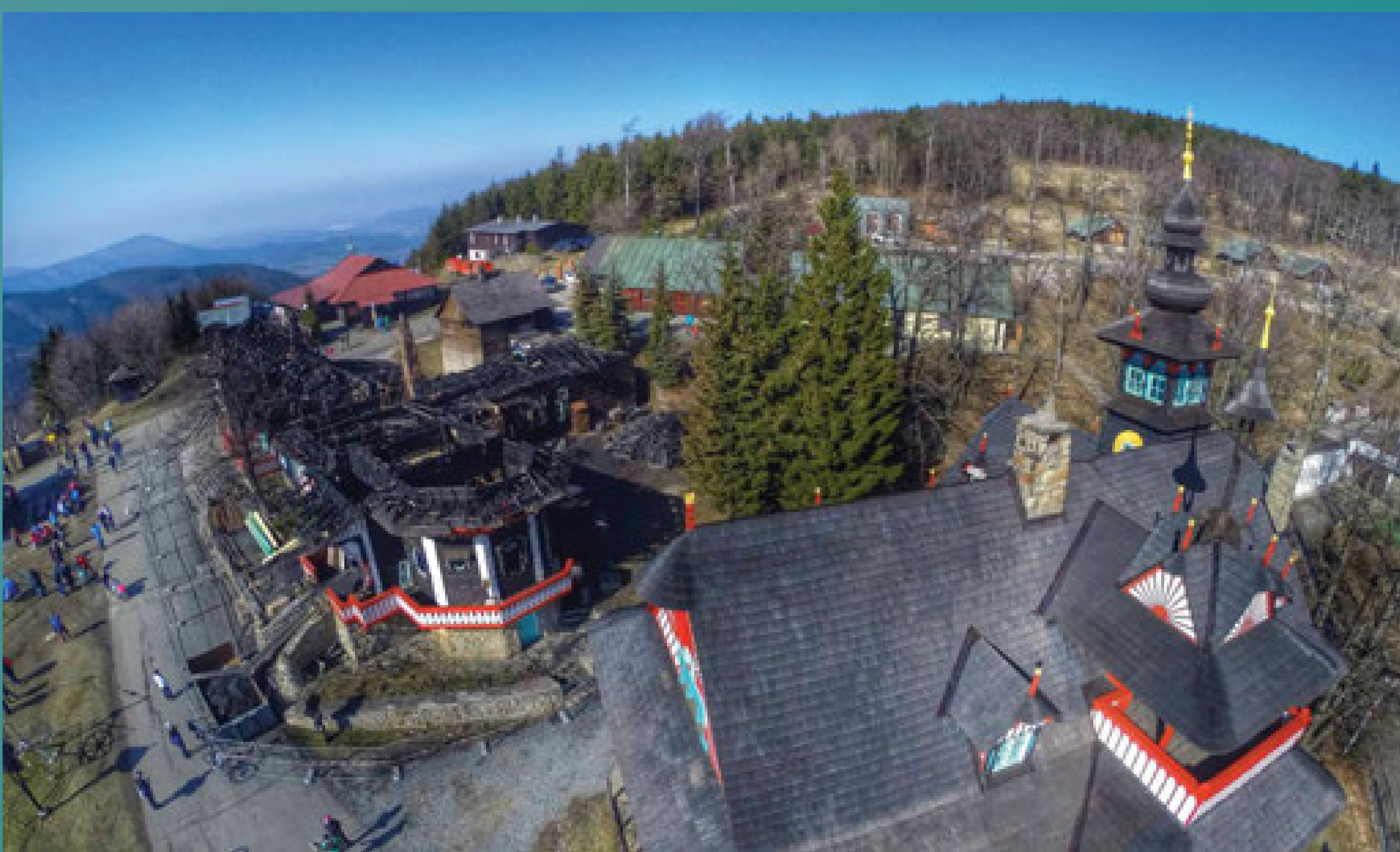
Dne 3. března 2014 vyhořela chata Libušín Požár likvidovalo třináct jednotek hasičů Zlínského a Moravskoslezského kraje se šestnácti cisternami. Škody na tomto historickém objektu jdou do desítek milionů korun. Ihned po požáru vznikla veřejná sbírka na obnovu Libušína
