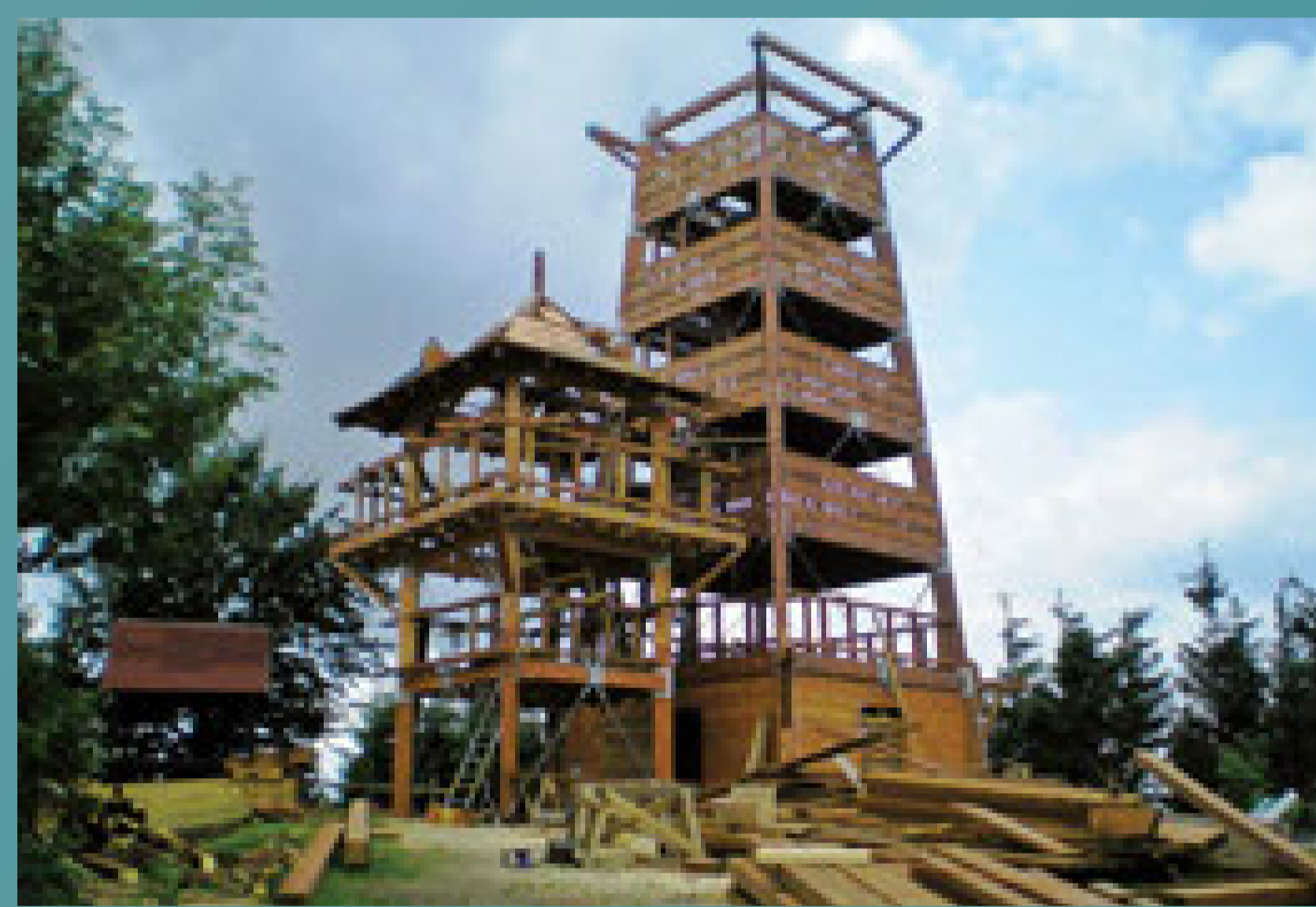
Stavba nové rozhledny na Velkém Javorníku (2013)
