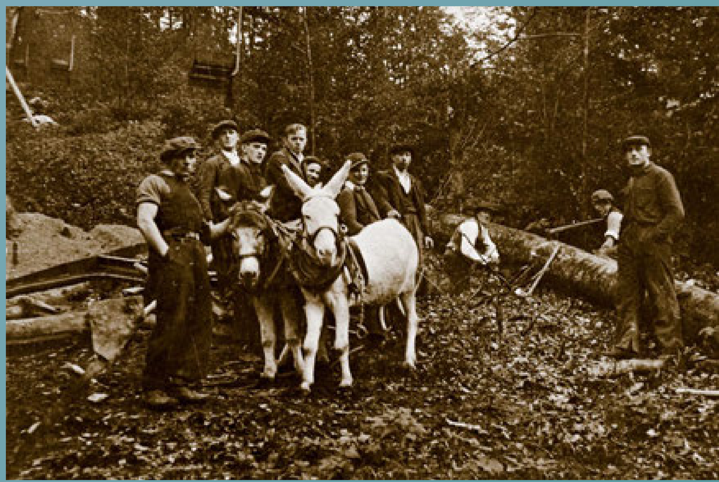
Výměna původních dřevěných podpěr za železné (1940)
