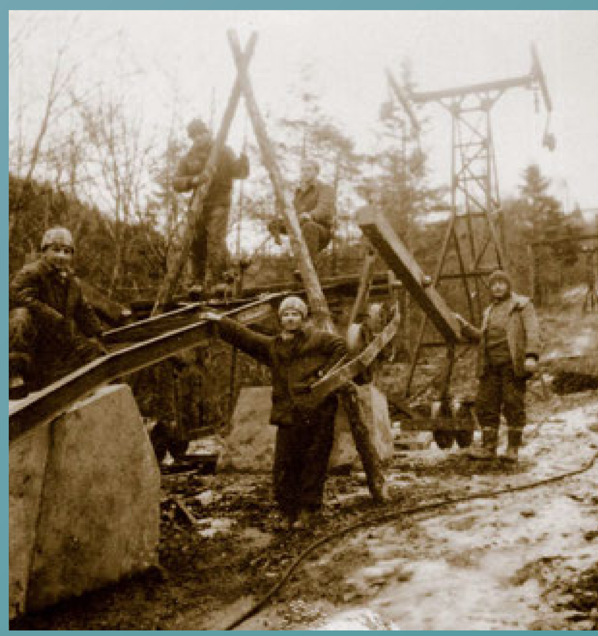
Rekonstrukce lanové dráhy Ráztoka–Pustevny (1957)
